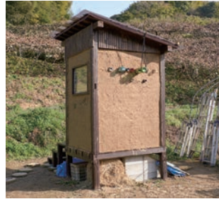
建設中のコンポストトイレ
