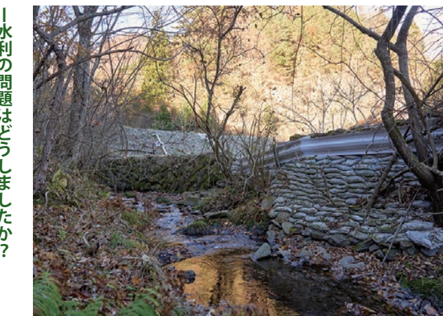
土のうを積み上げて復旧させた
