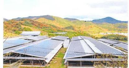
長谷川グループ牧場の牛舎では屋根部分に太陽光パネルを設置しエネルギーを蓄熱しています。蓄熱されたエネルギーは牧場内で発生するラニングエネルギーとして利用しています。また、牛舎の屋根に設置することで夏季の太陽光を遮断し牛舎内へ熱を伝えない事で家畜の快適な環境づくりに繋がります。また、太陽光パネルは発電時に、地球温暖化の主な原因である二酸化炭素を排出しませんので、地球温暖化の防止にも貢献ができます。
