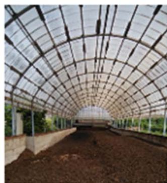
ロータリー攪拌式 堆肥舎
