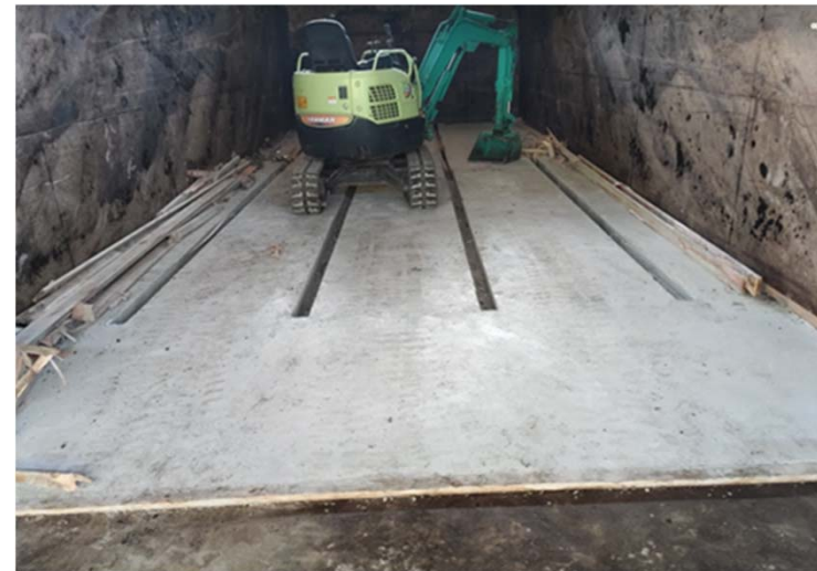
通気式堆肥舎への改造
